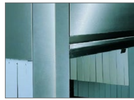
Con doble pared que reduce la pérdida de calor y el ruido, las puertas tienen doble pared con aislamiento.
